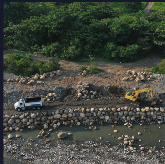
Construcciones de enrocados
